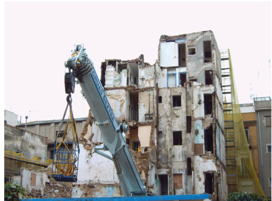
Démolition du bâtiment, "Forat de la Vergonya", septembre 2005
