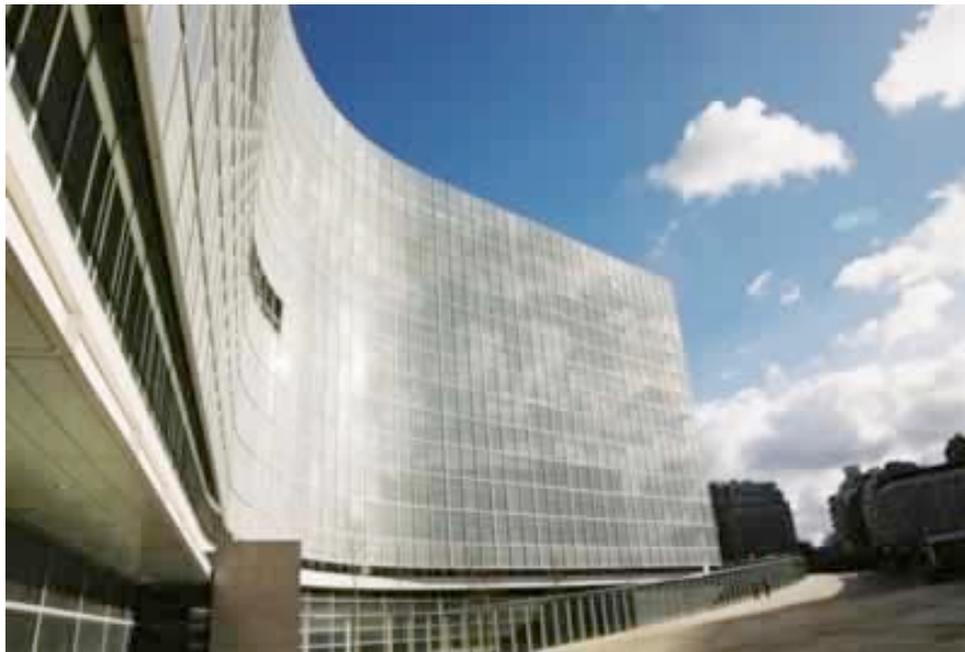
le bâtiment de la commission européenne.
